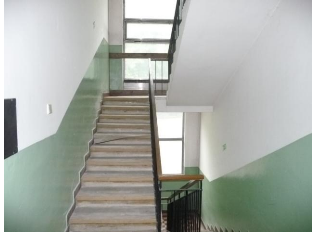
Schodisko v budove súp.č.485
